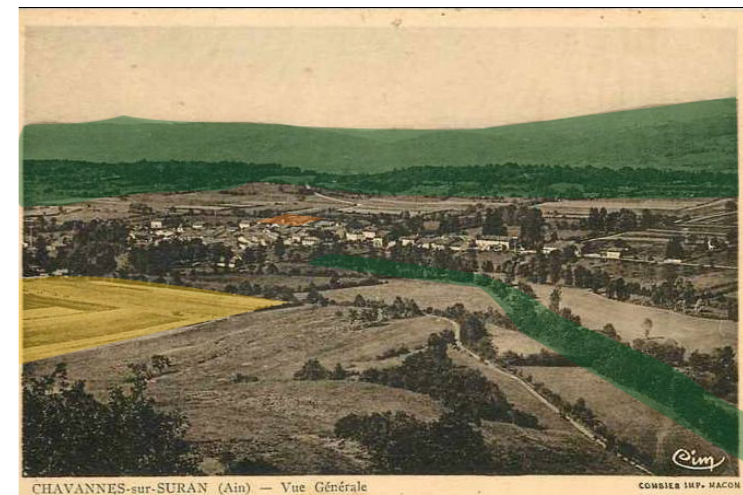
CHAVANNES-sur-SURAN (Ain) — Vue Générale
